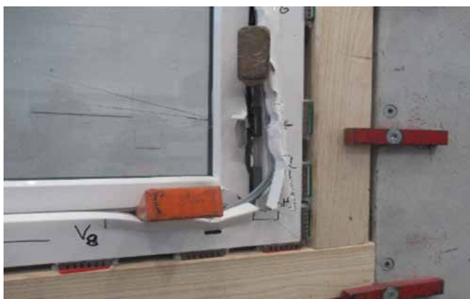
Schäden aus der manuellen Prüfung
